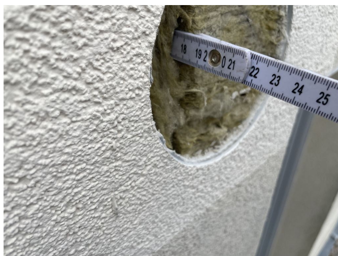
foto /6/ Měření tloušťky tepelné izolace v místě sondy S2 (180 mm)
