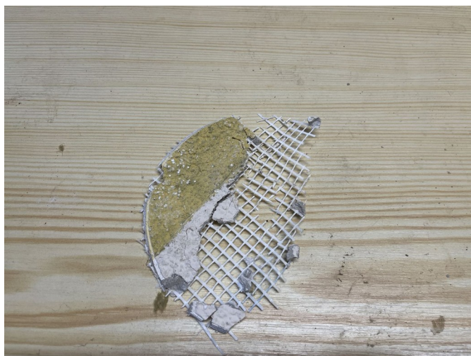
foto /17/ Ověření absence diagonál (sonda S1)
