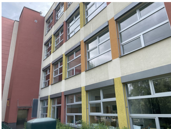
foto /13/ Severozápadní fasáda objektu C
