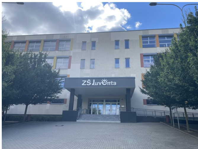
foto /9/ Severozápadní fasáda objektu A
