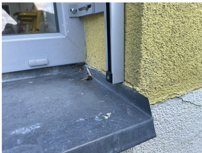
foto /21/ Parapetní plech
