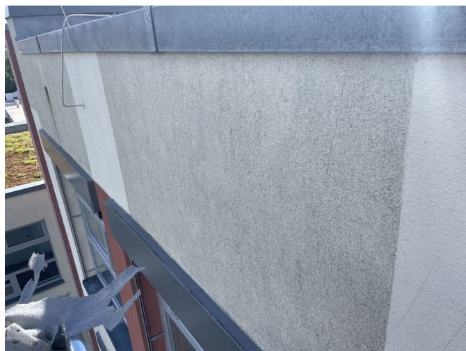
foto /22/ Ukončení u atiky
